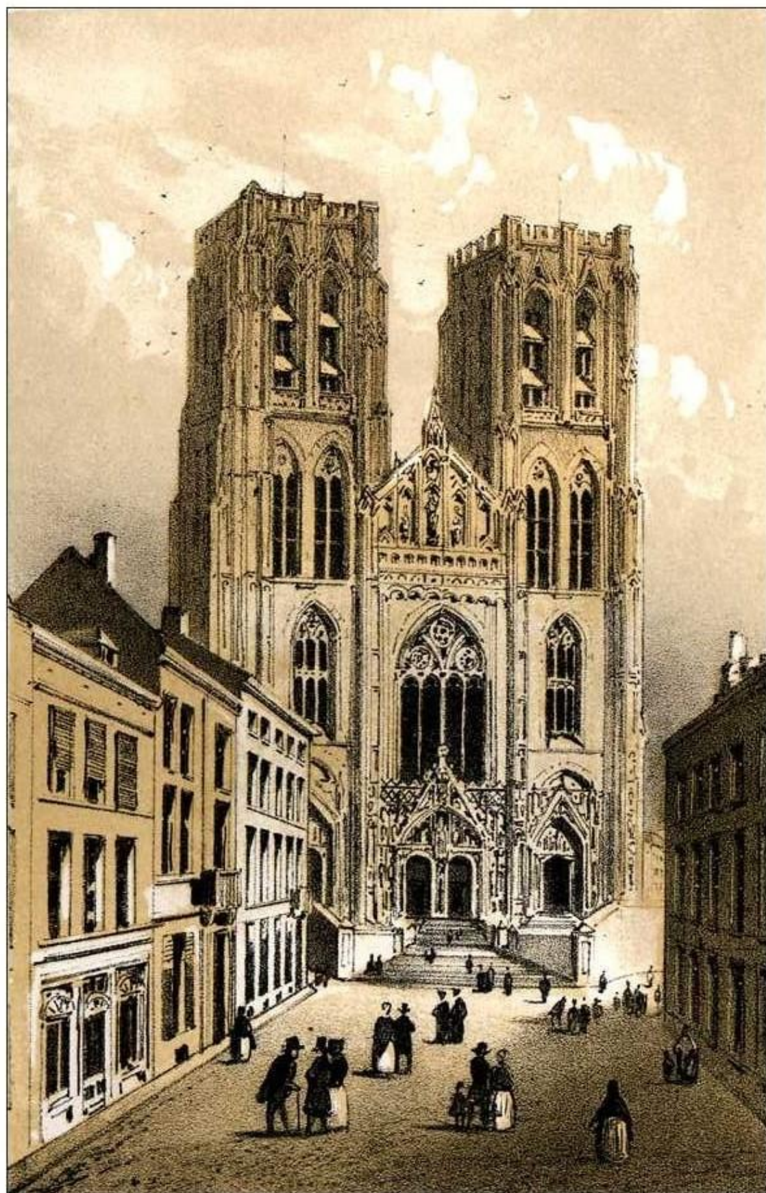
PORTAIL DE L'ÉGLISE STE-GUDULE, À BRUXELLES.
